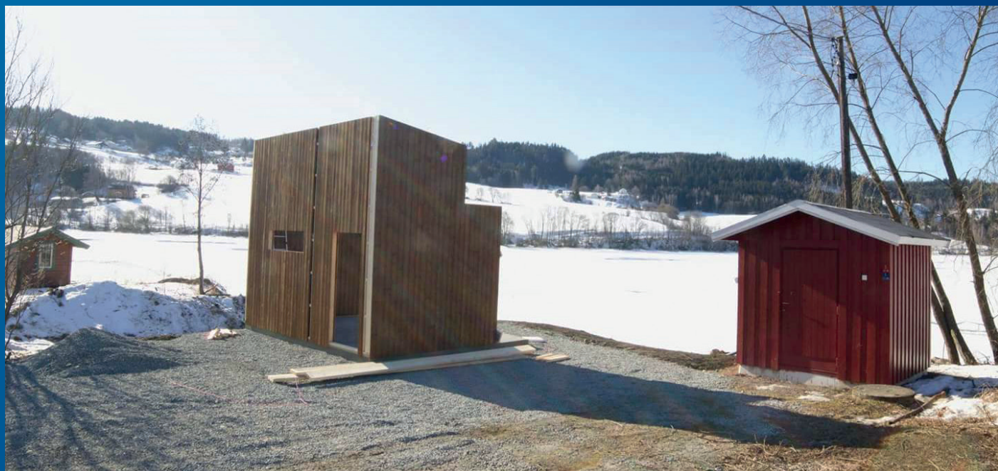
Fugleplattform Røykenvik, under oppbygging. Foto: Anne Gri Henriksen
